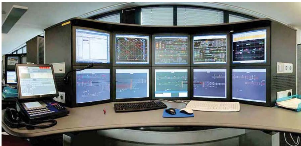
Abbildung 8 – ÖBB Bedienplatz: Zuglenkung mit ARAMIS [11]
